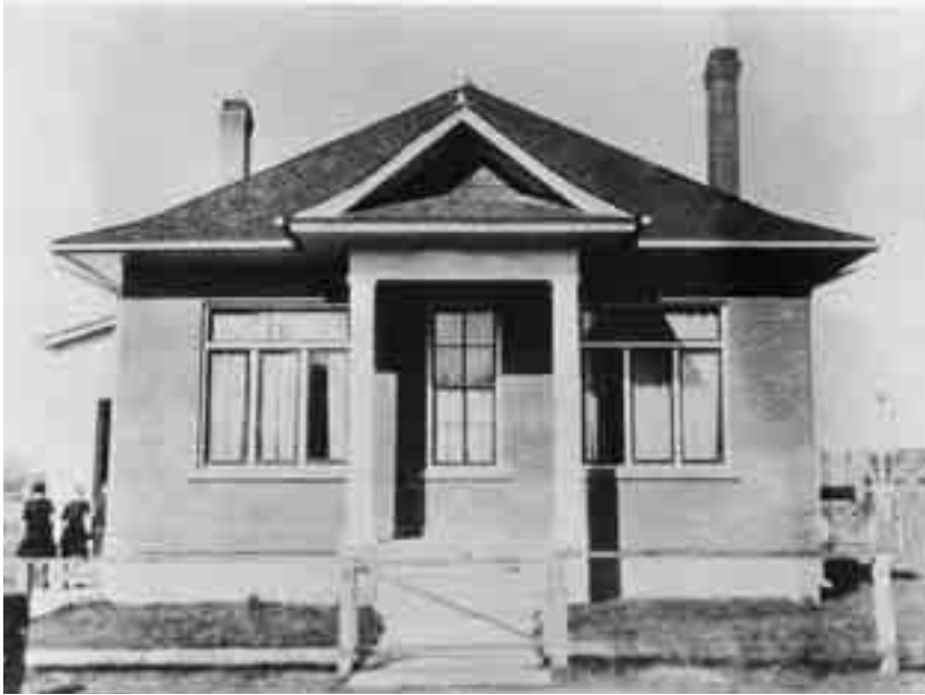
En este edificio funcionó el primer seminario de la Iglesia que se inauguró en 1912, junto a la escuela de segunda enseñanza Granite, en Salt Lake City, Utah.
