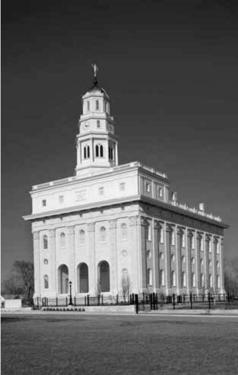
最初に神殿が建てられた用地に再建されたノーブー神殿。 最初のノーブー神殿の建設が進められていたとき、預言者ジョセフ・スミスは 「わたしたちには何よりも神殿が必要です」と宣言した。
