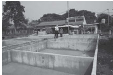
Kolam ikan baru yang siap digunakan.
