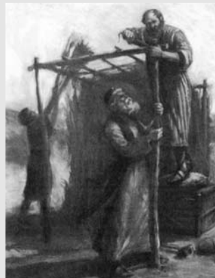
Szent sátor építése
