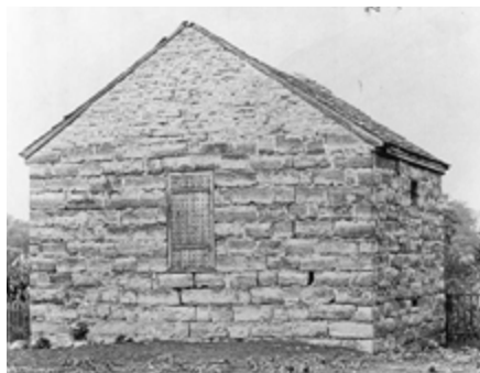
Das Gefängnis von Liberty, Missouri. Die Außenmaße des Gebäudes betragen knapp acht mal acht Meter, das Haus ist etwa vier Meter hoch, das Schrägdach nicht einbezogen. Das Gebäude wurde bis 1856 als Gefängnis benutzt, dann wurde es für unsicher erklärt.
