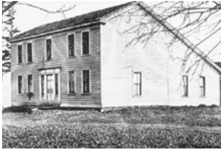
Das Haus von Friedensrichter Tarbell. Joseph und Emma wurden am 18. Januar 1827 in South Bainbridge (später Afton) im Staat New York von Zachariah Tarbell getraut. Das Haus ist inzwischen abgerissen worden.
