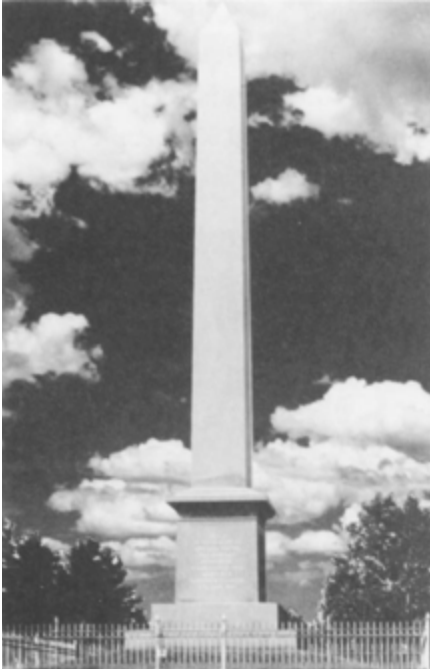
Vor allem Junius F. Wells war darum bemüht, zum hundertsten Jahrestag der Geburt des Propheten Joseph Smith an seinem Geburtsort in Vermont ein Denkmal zu errichten. Das Denkmal aus Granit besteht aus der Basis, der Säule und dem Deckstein. Die Säule ist 38 1/2 Fuß hoch und aus einem sechzig Tonnen schweren Block gehauen. Der Transport der Säule über die fast zehn Kilometer von der Eisenbahn bis zu ihrem Standort nahm zwanzig Tage in Anspruch. Dank dem Glauben und dem Einsatz von Bruder Wells gelang es, das Denkmal bis zur Weihung am 23. Dezember 1905 fertig zu stellen.
