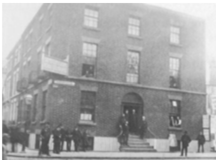
Dieses Gebäude in der Islington Street Nr. 42 in Liverpool diente von 1855–1904 als Sitz der Britischen Mission und als Büro für den Millennial Star.
