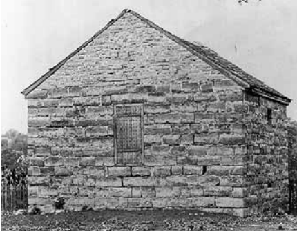
La prison de Liberty à Liberty (Missouri). Les dimensions extérieures du bâtiment sont 6,80 m de long, 6,70 mètres de large et 3,60 mètres de haut à la base du toit. Le bâtiment fut utilisé comme prison jusqu'en 1856, époque à laquelle il fut considéré comme insalubre.
