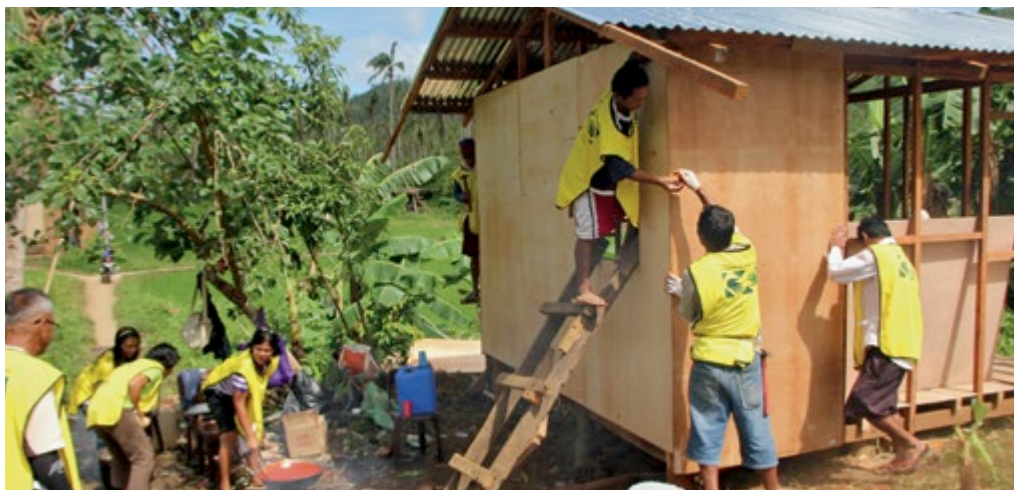
Des bénévoles clouent du contre-plaqué à la charpente d'une maison neuve, à Tacloban, aux Philippines.
