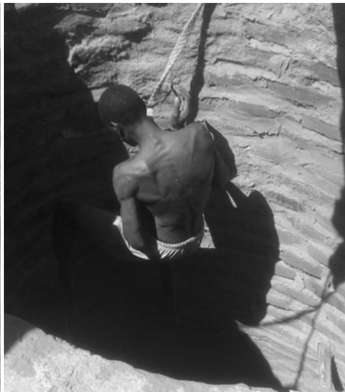
Wambua Kithome s'abaisse dans l'ouverture où il éclate des roches et creuse le futur puits.
