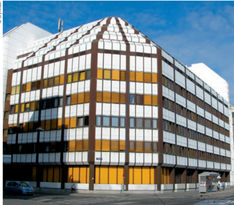
Le bâtiment des archives centrales des archives de l'État autrichien à Vienne-Erdberg (Autriche)
