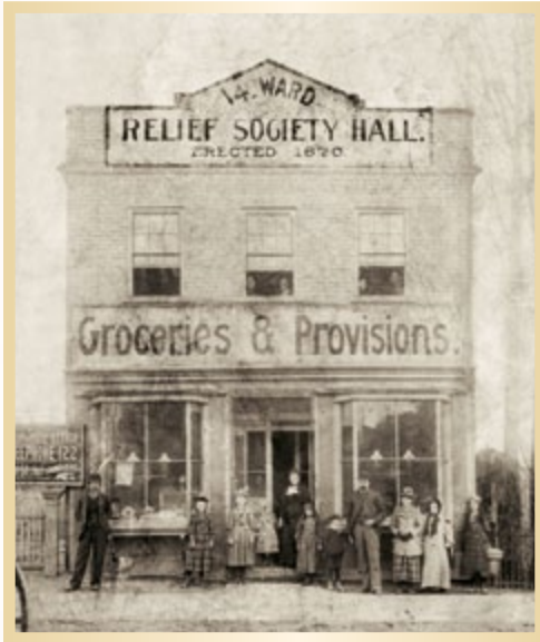
Salle de réunion de la Société de Secours, à l'étage d'une épicerie de Salt Lake City (Utah, États-Unis), 1892
