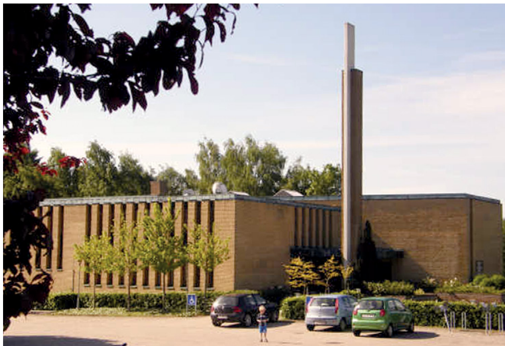
Københavns Stavs smukke bygning
