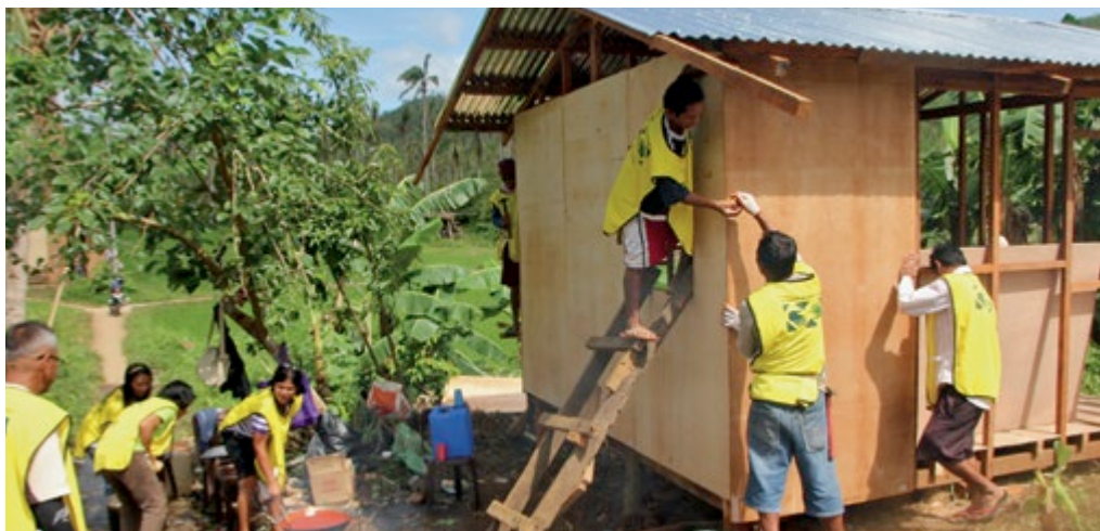
Доброволци заковат шперплат към рамката на една нова къща в Таклобан, Филипини.
