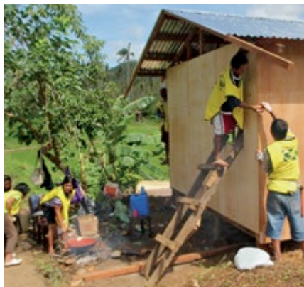
Կամավորները նրբատախտակ են ամրացնում նոր տան հենքին Տակլորանում, Ֆիլիպիններ:
